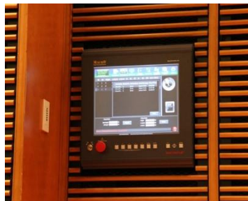
音樂廳的 3 組電動燈杆都各自連接了 1 台水平提升機，可透過備有輕觸式屏幕的 MACHO 舞動控制台(圖右下)，進行提升和下降的操作。水平提升機內堅固的鋼絲繩，需要通過天花金屬架(圖右上)的頂樓滑輪，再連接到滑輪下的燈杆(圖左)。
