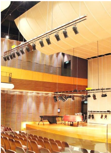
音樂廳的 3 組電動燈杆都各自連接了 1 台水平提升機，可透過備有輕觸式屏幕的 MACHO 舞動控制台(圖右下)，進行提升和下降的操作。水平提升機內堅固的鋼絲繩，需要通過天花金屬架(圖右上)的頂樓滑輪，再連接到滑輪下的燈杆(圖左)。
