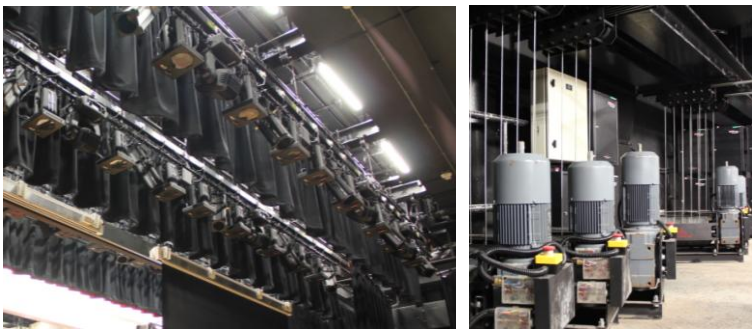
舞台燈都安裝在電動燈杆上，燈杆連接 MACHO 水平提升機，以進行精確提升和下降操作。
